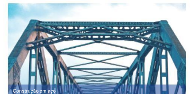
Construção em aço
